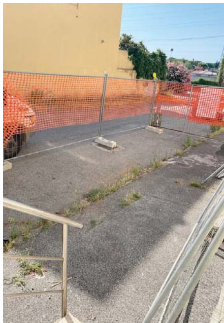
Apertura del cantiere
